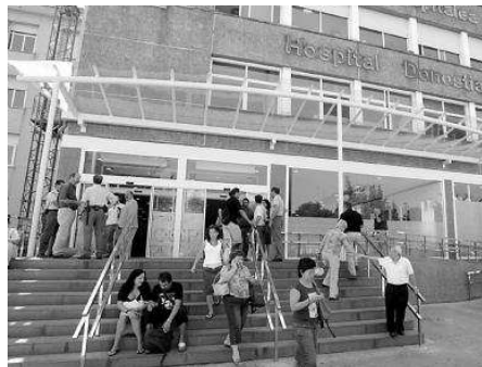
Fachada exterior del Hospital Donostia. FOTO: KARLOS CORBELLA
